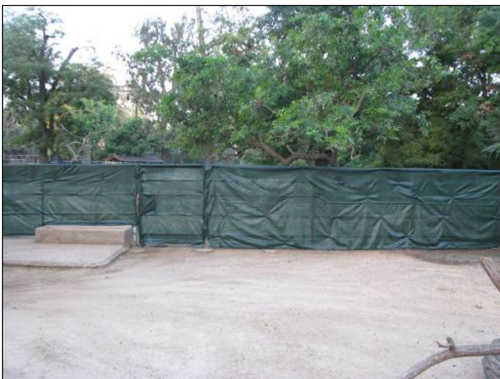
Malla d'ocultació instal·lada al clos existent al nord de la caseta de manteniment.
