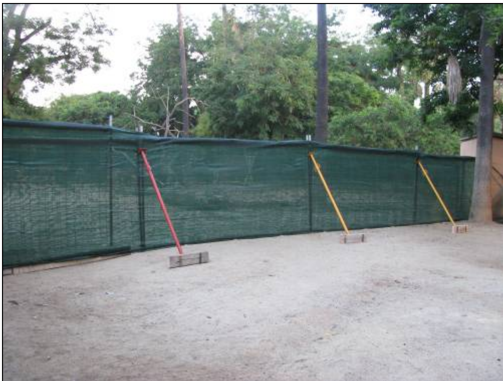
Tanca provisional amb malla d'ocultació instal·lada al sud de la caseta de manteniment.
