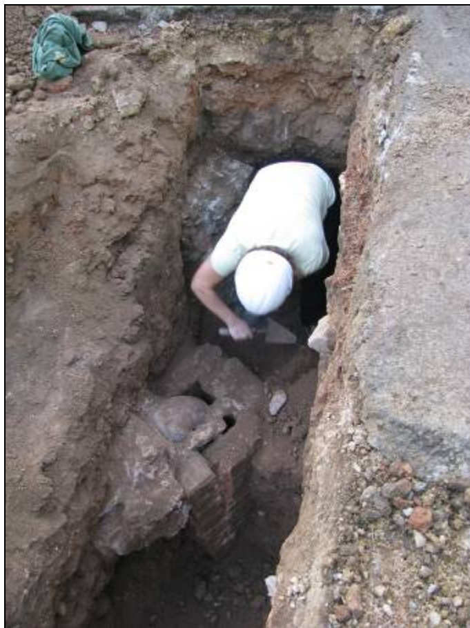
Excavació de les restes exhumades a la rasa 1.
